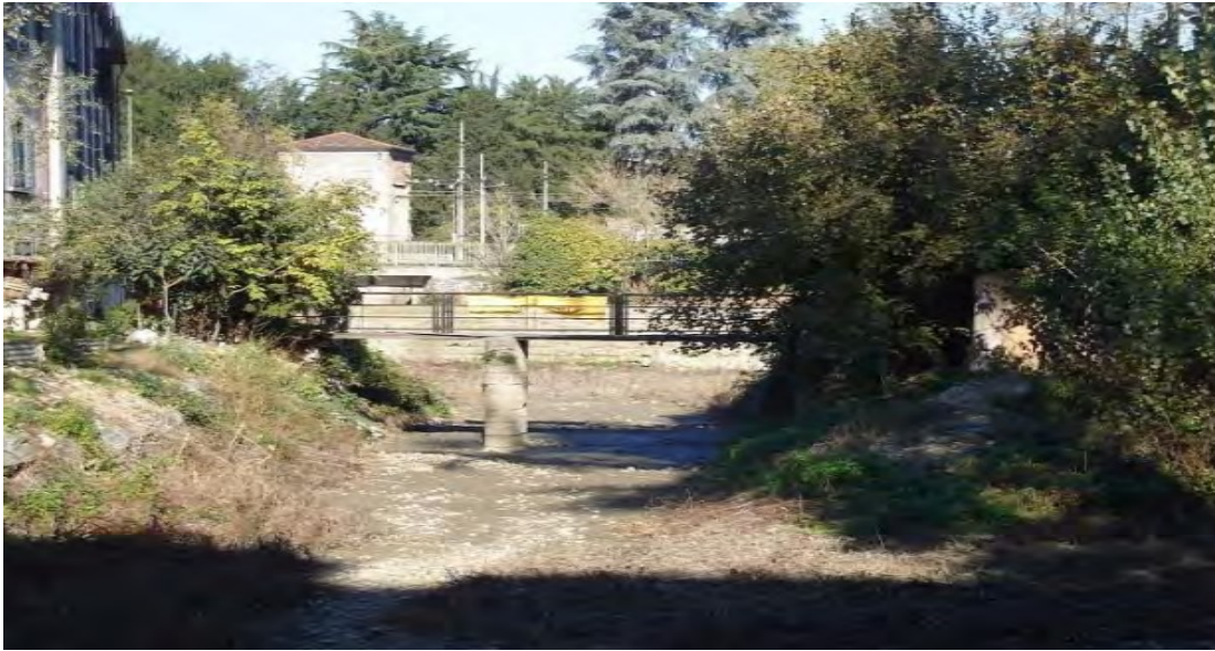
Fig. 2 – Il ponticello che collega l'ingresso all'isolotto centrale. Fonte: Circolo Legambiente "A. Langer" di Monza.
